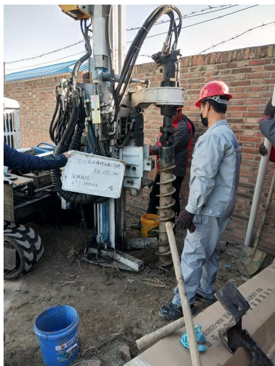
中空螺旋钻钻进
