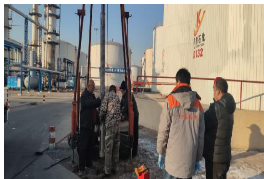
罐区钻探施工现场
