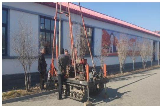
办公区钻探施工现场
