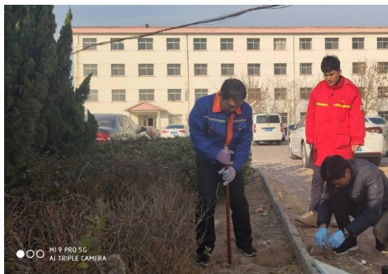
办公区 A 区钻探施工现场
