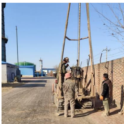
B1 污水处理区钻探施工现场
