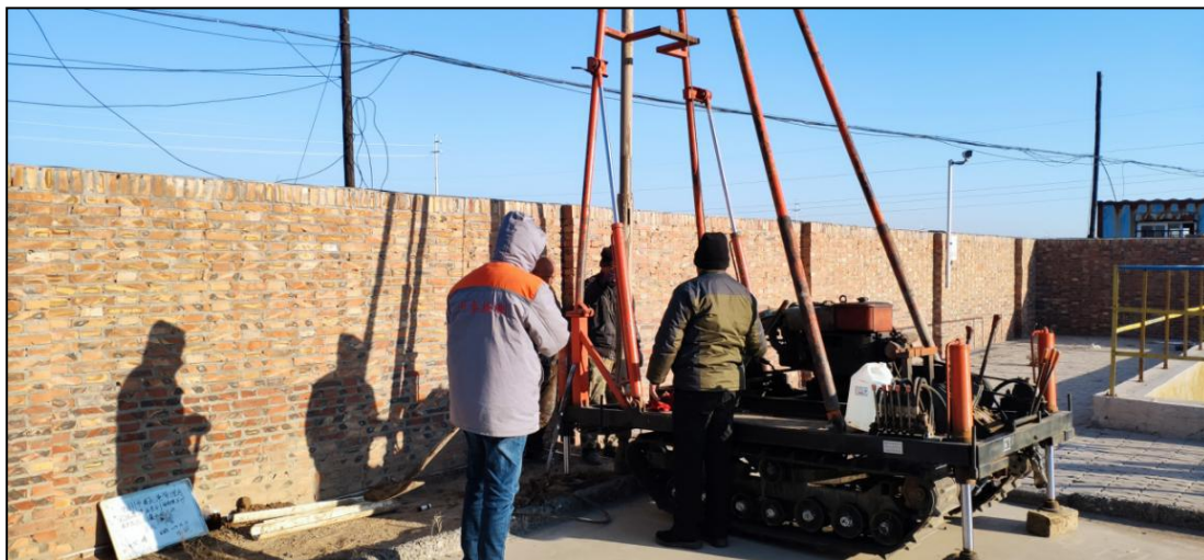
T4 污水处理区钻探施工现场
