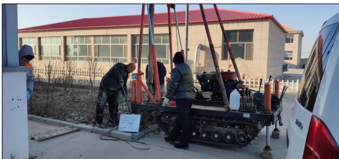
T2 精制厂房北侧钻探施工现场
